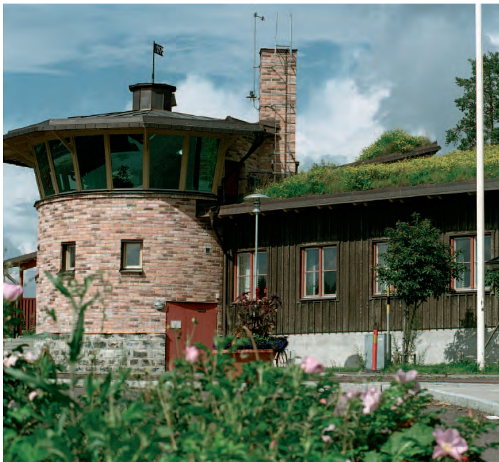
Vista del edificio de la empresa
